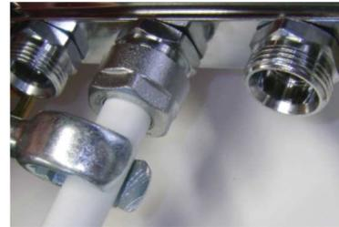
Mit der Hilfe von einem Schlüssel 27 mm. die Überwurfmutter bis zum Anschlag anschrauben.
