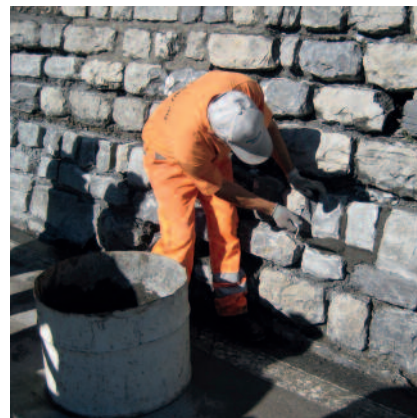
1. Pavifix CEM ROC per la rifinitura di fughe orizzontali e verticali
