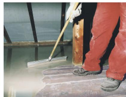
PCI Periplan Extra armé de fibre est excellent pour l'égalisation des planchers en bois et en panneaux de particules dans le cadre de travaux de rénovation et de modernisation.
