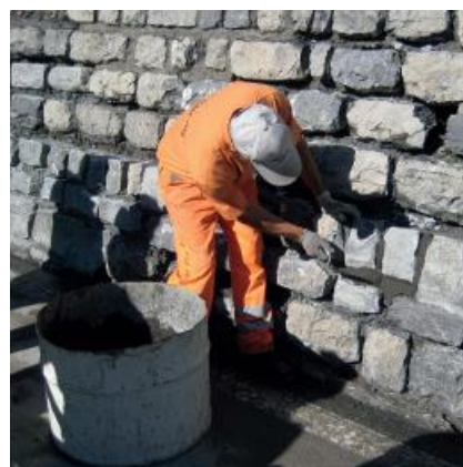
PCI Pavifix CEM ROC pour le jointoiment des joints horizontaux et verticaux.
