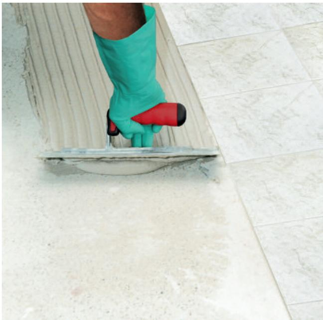
PCI Carrament gris est un mortier de lit moyen plastique-souple léger et facile à appliquer.
