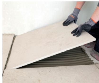
Mit PCI Carrament® grau können Naturwerksteinbeläge sicher im Mittelbettverfahren verlegt werden.
