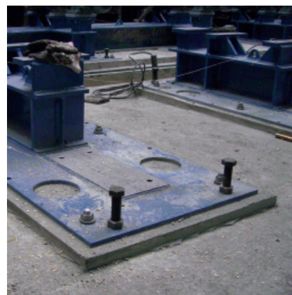
PCI Repaflow consente un collegamento senza giunture, fessure e cavità, garantendo il funzionamento silenzioso della macchina, con conseguente precisione di lavorazione e un'usura minore della stessa.
