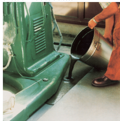
Le malte PCI Repaflow sono scorrevoli e consentono di riempire le cavità orizzontali in modo autolivellante
