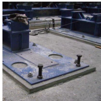
PCI Repaflow assure une liaison sans reprise, exempte de fissures et vides, qui permet une marche régulière des machines et dès lors un travail plus précis et une moindre usure des machines.
