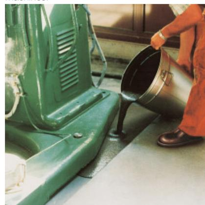
PCI Repaflow est coulant et remplit par gravité les espaces creux horizontaux.
