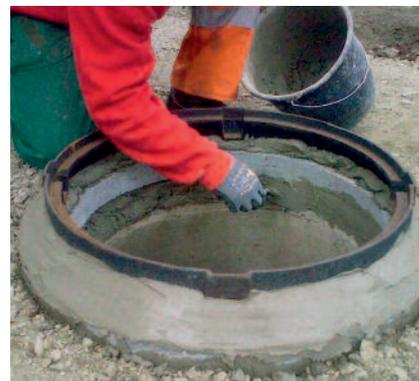
Schachtfutter einmörteln mit PCI Polyfix plus.
