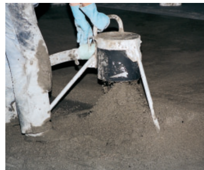
PCI Novoment Z3 für beschleunigt härtende Estriche hat eine lange Verarbeitbarkeitsdauer von ca. 1 Stunde und ist – auch bei höheren Temperaturen – für Pumpenförderung geeignet.
