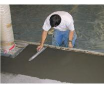
PCI Novoment M1 plus est un ciment rapide pour chapes et dès lors une solution économique et particulièrement pratique pour la mise en place de petites surfaces et de parties de chapes qui doivent être utilisées rapidement.
