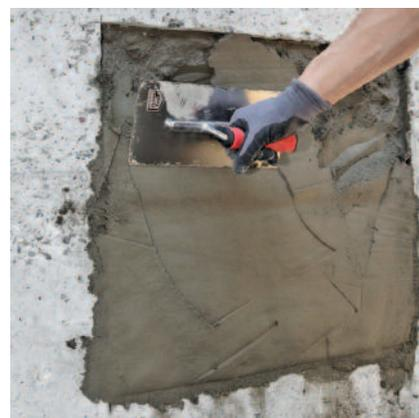
La malta da ripristino PCI Nanocret R4 Rapid è subito modellabile e si indurisce anche con temperature a partire da 1 °C.
