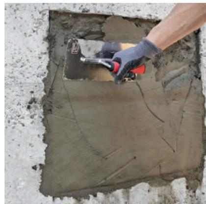
Le mortier de réparation rapide PCI Nanocret R4 Rapid est immédiatement modelable et sèche également aux températures à partir de 1 °C.
