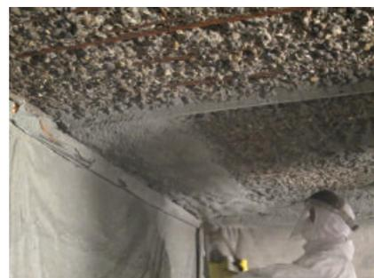
PCI Nanocret R4 SA pour la réparation et le reprofilage d'éléments de construction en béton soumis à des sollicitations.
