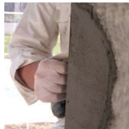
Ripristino di spigoli e bordi: solo una delle svariate possibilità d'impiego della malta da ripristino universale PCI Nanocret R2
