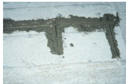
Afin de garantir un recouvrement complet des armatures, PCI Nanocrete AP peut également être appliqué sur le support adjacent.
