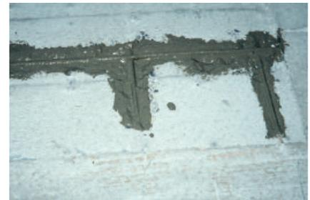
Um eine komplette Abdeckung der Bewehrung sicherzustellen, darf PCI Nanocret AP auch auf den angrenzenden Untergrund aufgetragen werden.
