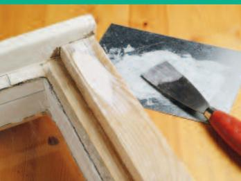
Auf die gesäuberte Reparaturstelle wird **bestaPROFI®** aufgebracht. Anschliessend schleifen und/oder überstreichen. Bei dickeren Schichten empfiehlt sich ein zweifacher Auftrag.
