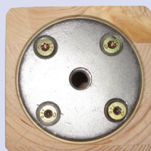
SPP-Verbinder einsetzen und verschrauben
