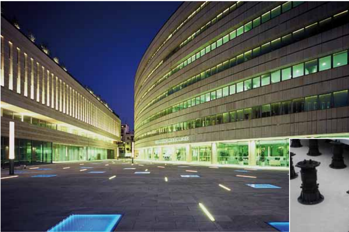
Terrasse auf Stelzlägern mit grossen Marmorplatten
