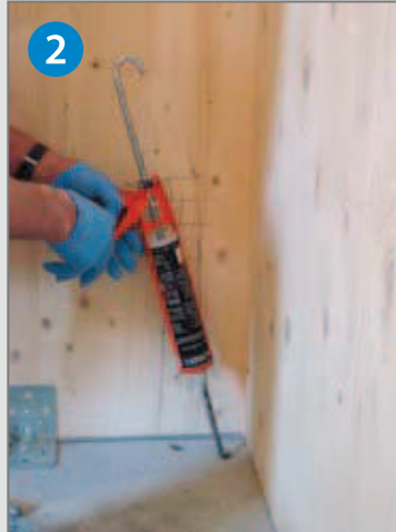
Einspritzen der chemischen Verankerung (Vinylester) in die Bohrung
