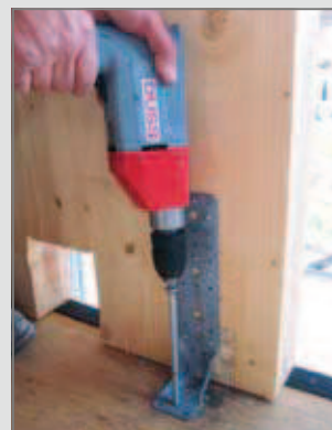
Positionierung des Winkelverbinders WKR und Befestigung an der Holzwand mit Spezialschrauben
