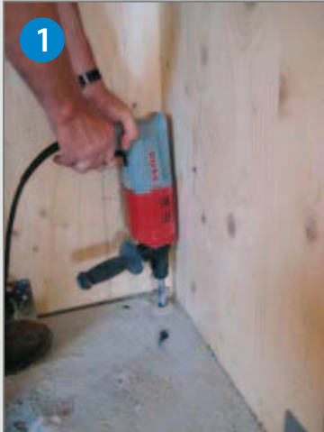
Bohren des Stahlbetons und ausblasen
