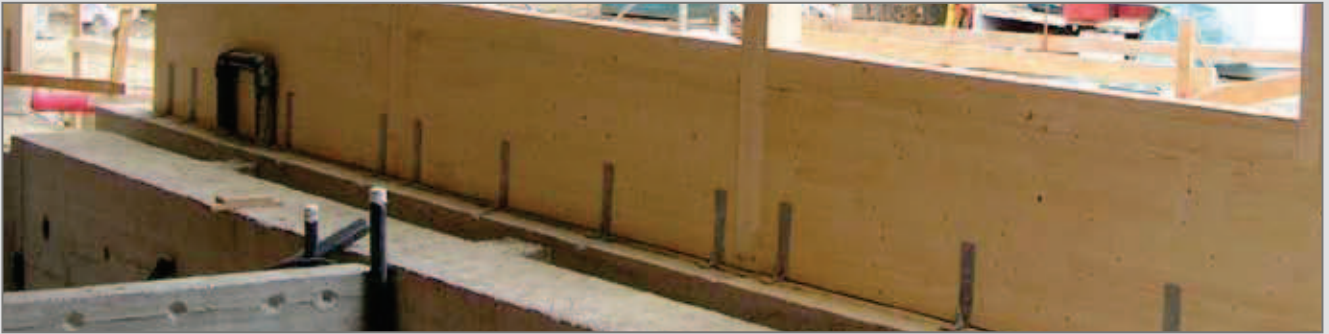
Winkelverbinder auf Betonplatte oder streifen Fundament: typische Anwendung für Holzhäuser
