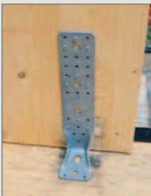
Positionierung des Winkelverbinders WKR und Befestigung an der Holzwand mit Spezialschrauben
