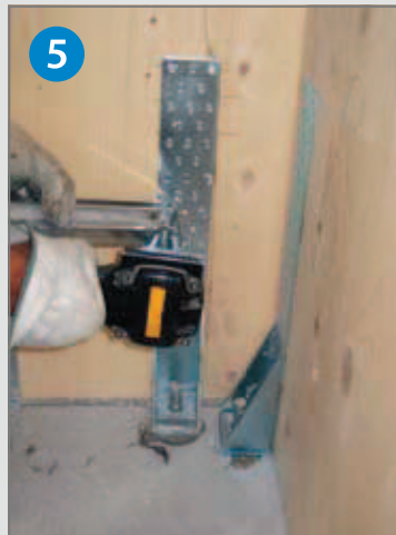
Ausnagelung der Rückenplatte
