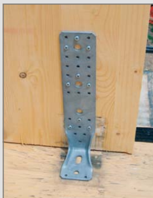
Posa in opera dell' angolare WKR e fissaggio alla parete mediante viti speciali
