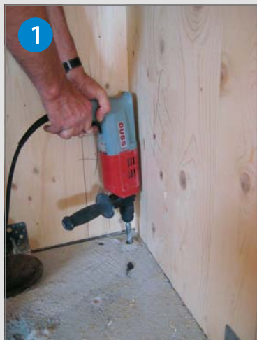
Foratura del cemento armato e pulitura del foro
