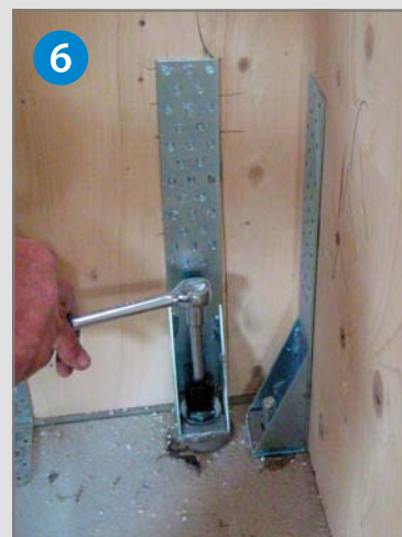
Posizionamento del dado mediante un' adeguata coppia di seraggio
