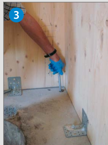
Posizionamento della barra filettata
