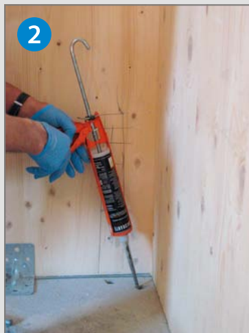
Iniezione dell' ancorante chimico vinilestre nel foro
