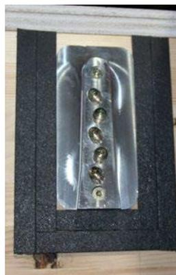
Das Brandschutzlaminat wird rund um den SHERPA-Verbinder auf der Holzoberfläche angebracht und quillt bei 150°C auf.
