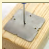
Bohrung mit Schablone anreißern
