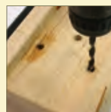
Vorbohren für Halteschraube und Verbinder
