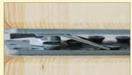
**Anwendung:** Sperrt und ist belastbar entgegen der Einschubrichtung z. B. bei Windsogkräften.
