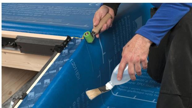
25. Seitlich die Lagen SOLITEX WELDANO miteinander verschweissen.
