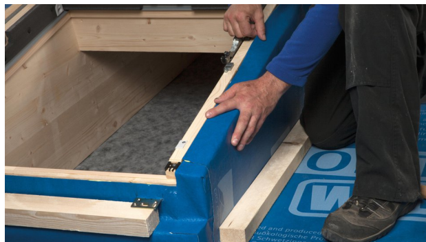
22. SOLITEX WELDANO entlang der Rahmenkante verkleben. Bahn mit Dehnschlaufe in das Kleberbett legen. Kleber dabei nicht ganz flach drücken, damit ggf. Bewegungen aufgenommen werden können.
