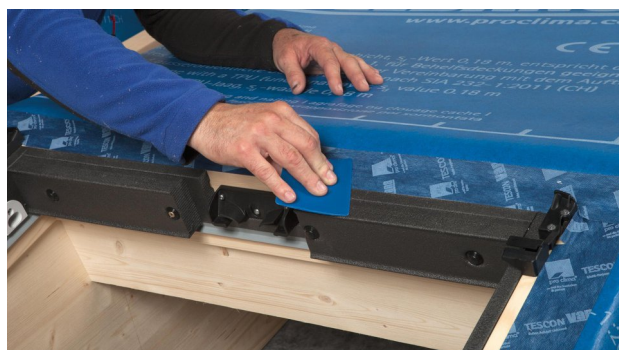
26. TESCO VANA zur praktischen Montage-Fixierung verwenden.
