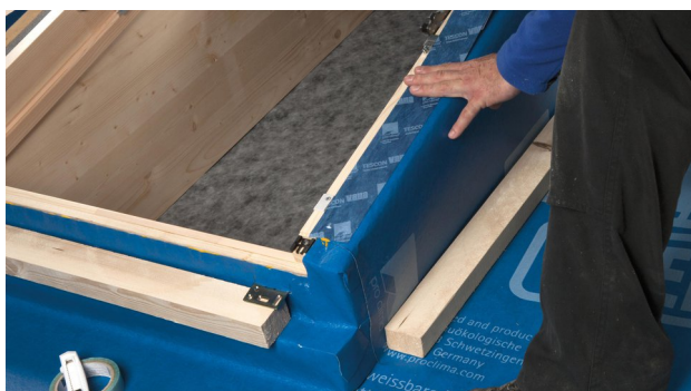
23. TESCO VANA zur praktischen Montage-Fixierung verwenden.
