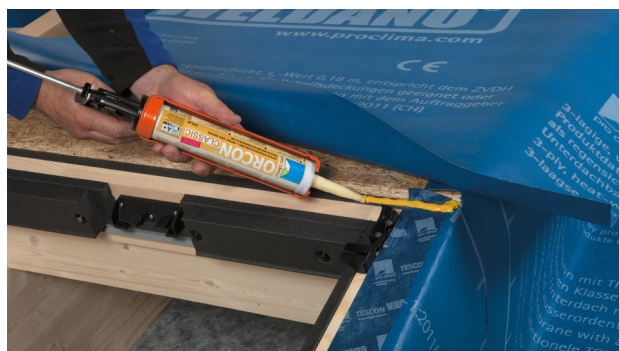
24. Flächige SOLITEX WELDANO mit ORCON CLASSIC am oberen Fensterrahmen verkleben.
