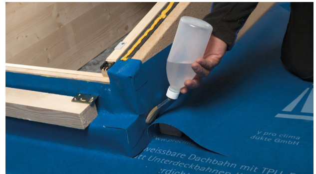
20. Unteren Eckbereich verschweißen.
