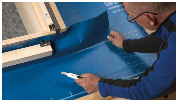
4. Horizontalschnitt bis Aussenkante des Fensterrahmens/Dämmrahmens.
