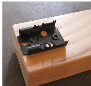
Anfang-Unterteil, sowie den Mittel-Verbinder für das erste Terrassenbrett montieren. Mittel-Verbinder nur leicht festziehen, sodass ein einführen des Brettes möglich ist
