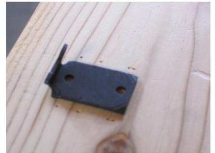
Anfang-Oberteil entsprechend den Markierungen festschrauben, Gecko-Mittel-Verbinder entfernen, Terrassenbrett einhängen und Gecko-Mittel-Verbinder wieder leicht festziehen. Nächstes Terrassenbrett ansetzen und vorherigen Mittelverbinder fest ziehen
