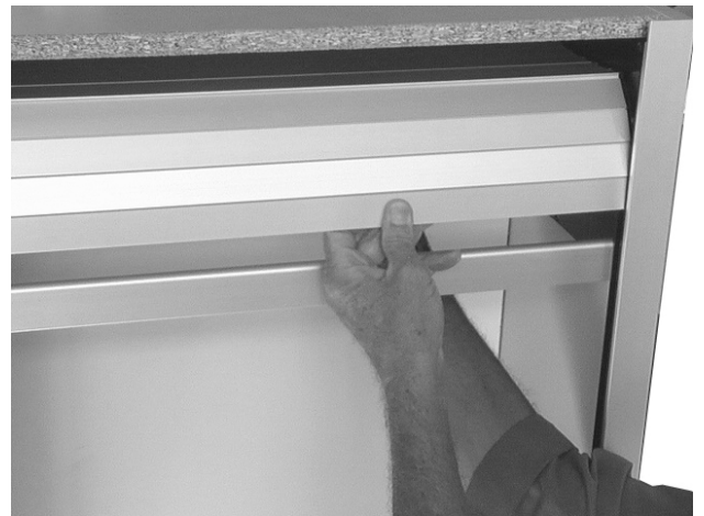
Rollladen in Führungsprofil einführen
