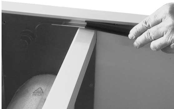
Kunststoff-Führungsprofil einlegen
