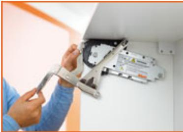
Der Kraftspeicher wird montiert. Das Hebelpaket kann werkzeuglos aufgesteckt werden.
