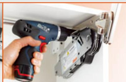
Die Kraftspeicher werden stufenlos – mittels Skala – auf das jeweilige Frontgewicht eingestellt.
