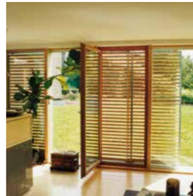
Praktisch: Ein- und Aushängen sowie Höhenverstellung der Schiebeläden von der Rauminnenseite her.
