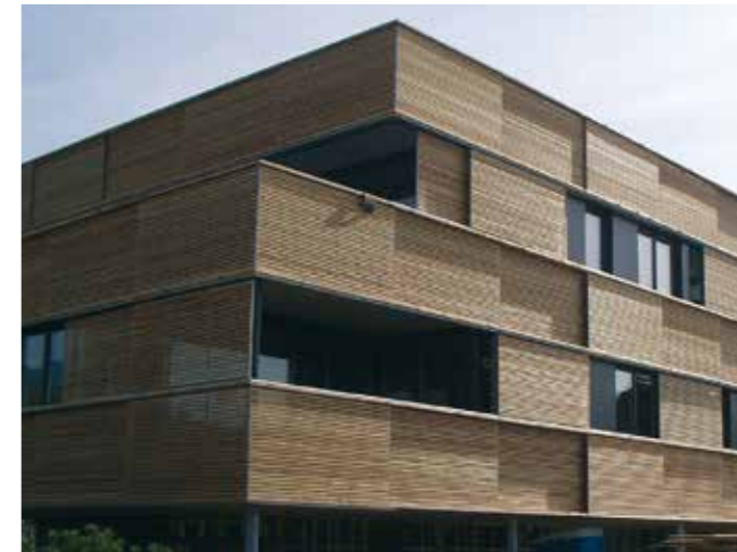
Hohe Flexibilität: sehr breite Ausführungen und unterschiedliche Anordnung der Schiebeläden möglich.
