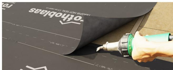
Membrana traspirante composta da 2 strati monolitici in TPEE e doppio rivestimento antiscivolo in PET per l'applicazione diretta sul lato freddo del coibente termico.
