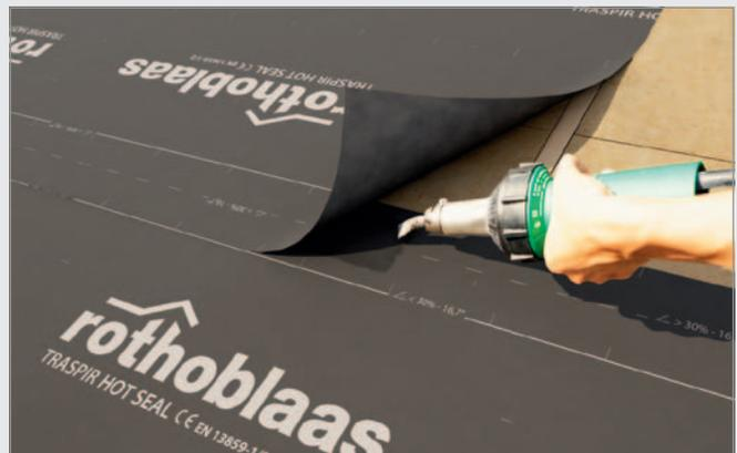
Spezielle diffusionsoffene Bahnen zur Unterdachabdichtung
