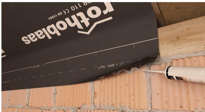
Adesivo a base d'acqua, privo di solventi, adatto soprattutto per pellicole plastiche, ad esempio in polietilene e polipropilene, per la realizzazione di giunzioni a tenuta d'aria tra membrane e altri materiali edili. A essiccazione fisica, non filamentoso.
