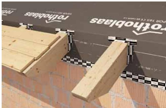
Schermo freno vapore a 3 strati in PP per la posa sul lato caldo del coibente in copertura.
