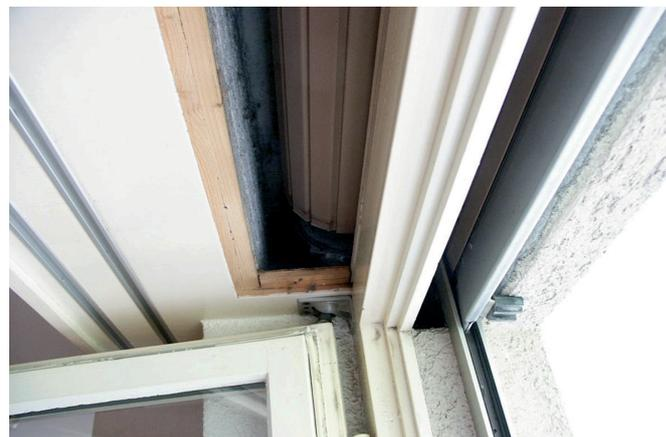
(Bild) Storenkasten Revisionsdeckel unten.
