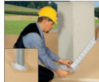
Durchdringung Traversée Penetration
