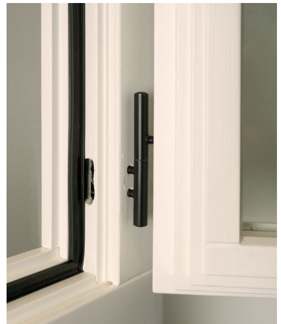
Einbohrband werk14, Ausführung bombiert Stahl schwarz lackiert
