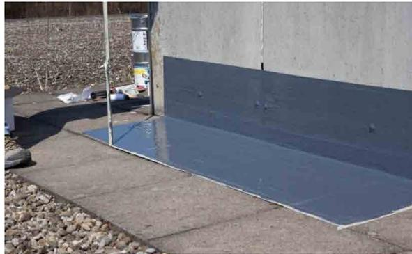
Fertigstellen der Zweitbeschichtung durch entfernen der Abdeckbänder.
