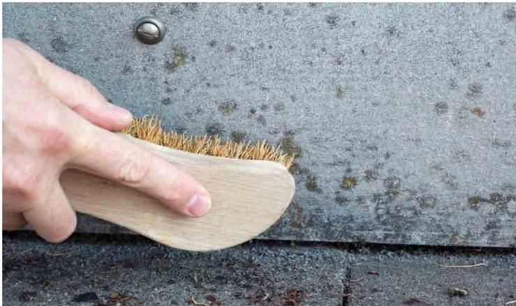
Eine gute Reinigung entscheidet über die Benetzung und Haftung von Aqua Protect Flex auf dem Untergrund und somit über den Erfolg (Dichtheit) der Abdichtung.
