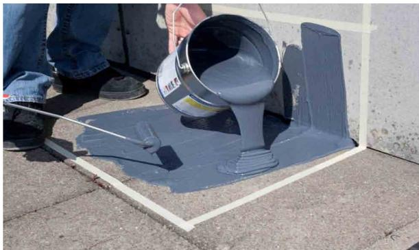
Das Auftragen von Aqua Protect Flex liquid erfolgt entweder direkt aus dem Gebinde oder durch Entnahme mit Roller, Pinsel oder Spachtel. Hierbei muss aber beachtet werden, dass kein Schmutz ins Gebinde gelangt.
