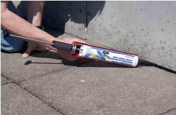
Aqua Protect Flex mit einem Spachtel glatt abziehen, kein Abglättmittel verwenden, da dieses die Haftung zwischen Aqua Protect Flex und Aqua Protect Flex liquid negativ beeinträchtigen kann. Das Abziehen muss innerhalb der Verarbeitungszeit von max. 30 Minuten (bei 23°C/50%rf) erfolgen.
