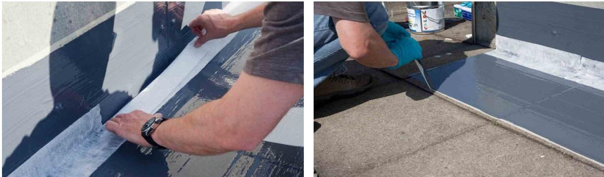
Fertigstellen der Erstbeschichtung durch Entfernen der Abdeckbänder, innerhalb der Verarbeitungszeit von Aqua Protect Flex liquid.
