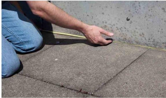
Zur Vermeidung einer Dreiflankenhaftung sowie zur Erzielung einer geeigneten Fugendimensionierung müssen die Fugen gegebenenfalls mittels Rundschnur hinterfüllt werden.
