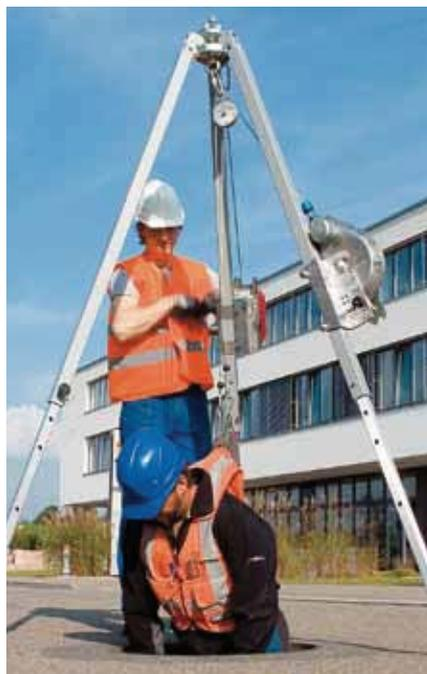
Beim Einstieg in schwer zugängliche Engräume (z. B. Tanks, Silos, Schächte, Kanalisationen, etc.) muss die absteigende Person durch eine zweite Person abgesichert werden, um bei einem eventuellen Zwischenfall (Gase, Dämpfe, etc.) die sichere und schnelle Bergung der gefährdeten Person sicherzustellen. SpanSet bietet mit den bewährten und bedienerfreundlichen Anschlagseinrichtungen in Kombination mit Höhensicherungsgeräten mit Rettungskurbel und Lastwinden die sichere Lösung dazu.
