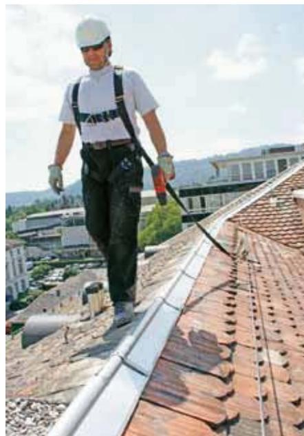
**RoofTop** Praktische Sicherung auf Dächern dank speziellen Dachverankerungen.
