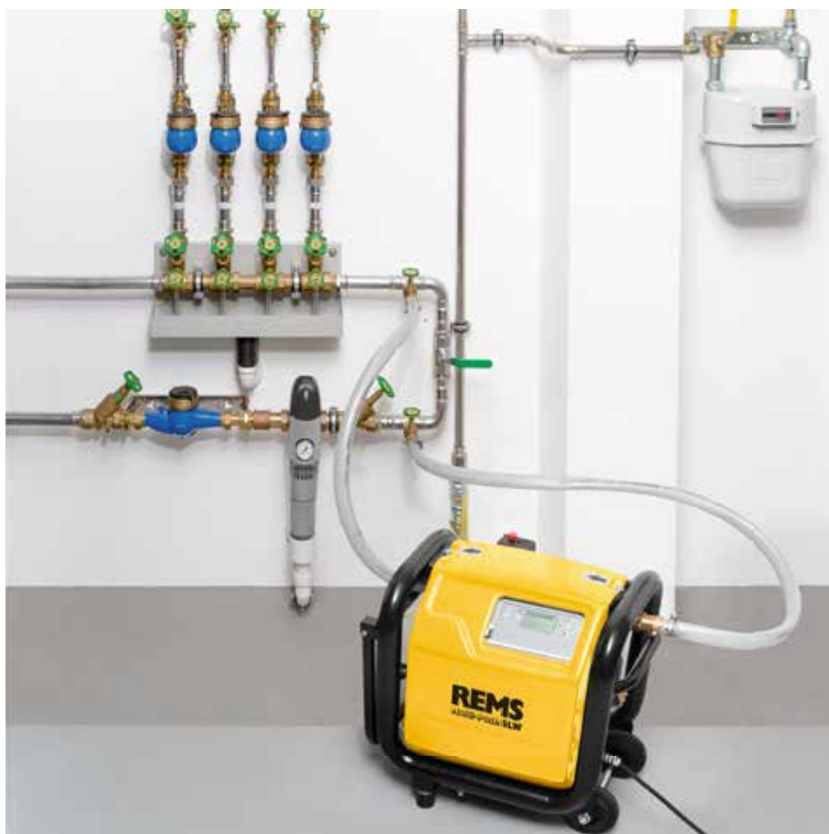
Flussaggio di impianti di acqua potabile
