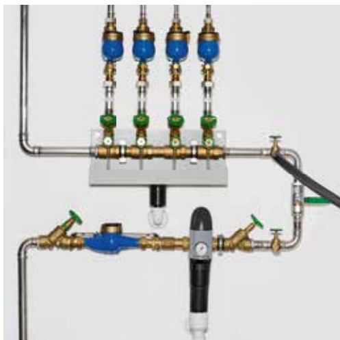
Druck- und Dichtheitsprüfung mit Wasser
