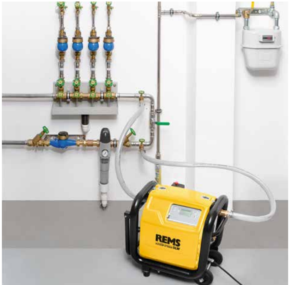
Spülen von Trinkwasserinstallationen
