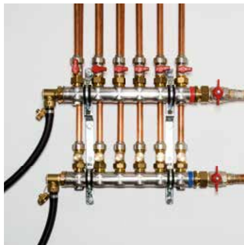
Spülen von Radiatoren- und Flächenheizsystemen
