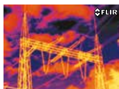
Inspection de lignes à haute tension
