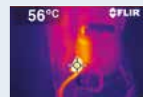
Das sieht eine Wärmebildkamera.
