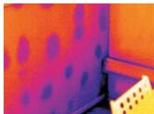
Das Wärmebild zeigt die Klebestellen von Rigipsplatten.
