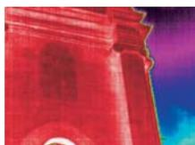
Das Wärmebild zeigt eine verborgene Fensterkonstruktion, die für das menschliche Auge nicht sichtbar ist.
