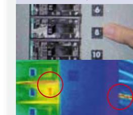
Les problèmes de connexion électrique, de câblage ou liés à d'autres composants sont clairement mis en évidence sur les images infrarouges. Ils sont faciles à localiser et à réparer. Les connexions surchauffées sont parfaitement visibles sur l'image thermique.
