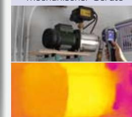
Die Überprüfung dieser Wasserpumpe zeigt keine Mängel. Das Infrarotbild belegt, dass sich Wasser im Pumpenzylinder befindet und keine Gefahr einer Überhitzung der Pumpe besteht.
