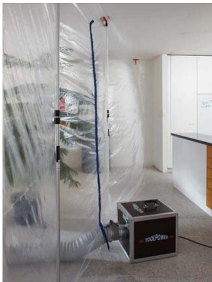
Eine funktionierende Staubwand bildet eine Ausbuchtung zur Baustelle hin. Der leichte Unterdruck am Arbeitsort verhindert, dass sich der Staub ausbreiten kann.
